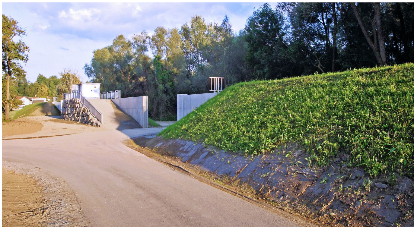
Der neue Hochwasserschutzdamm in Langenstein.
