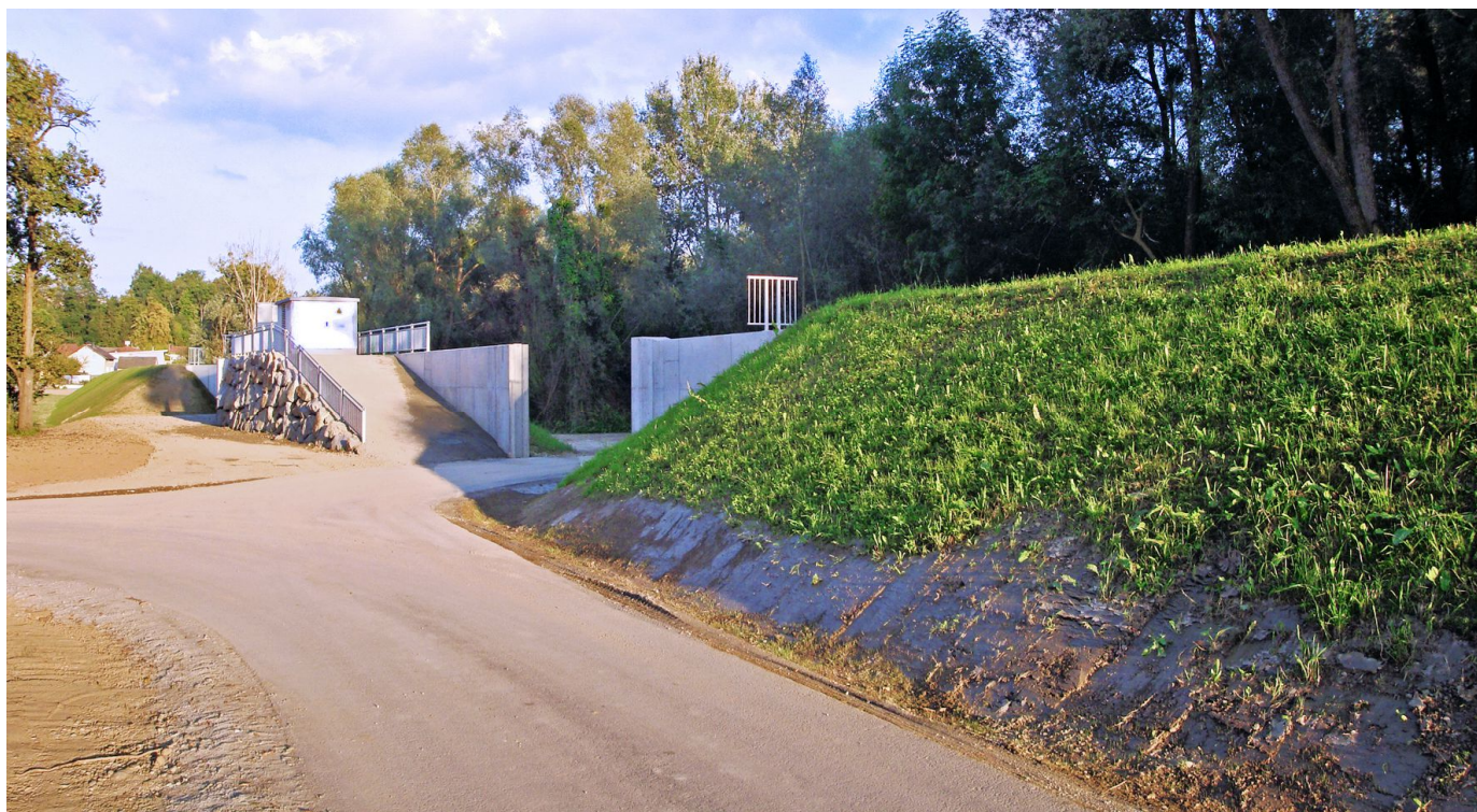
Der neue Hochwasserschutzdamm in Langenstein.
