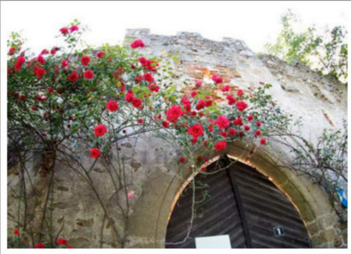
Ruine Spilberg, die durch einen engagierten Verein wieder aufblüht
